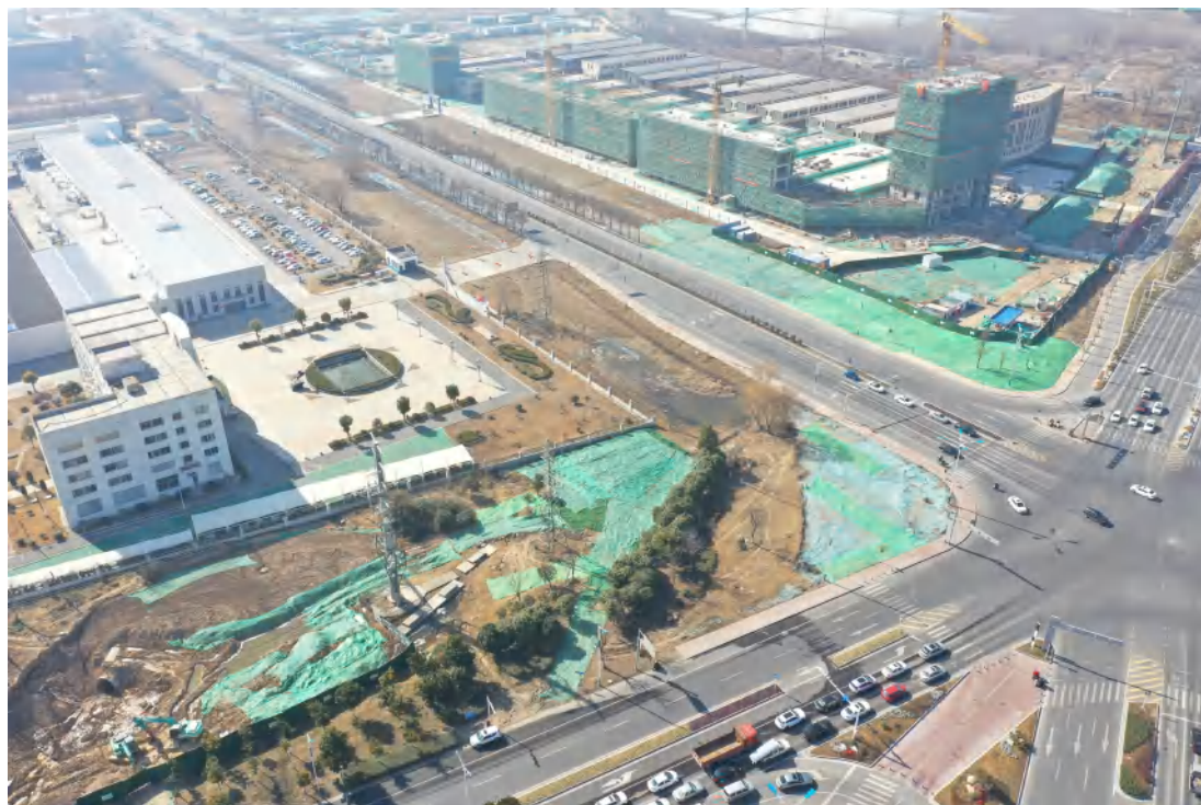
一期管道作业区
