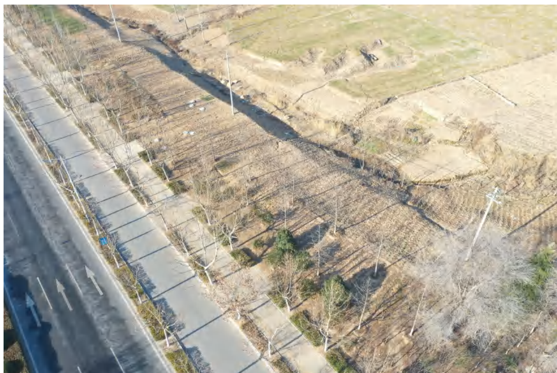
二期穿越作业区
