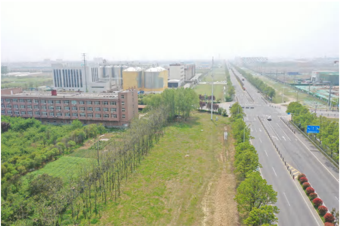
一期管道作业区现状
