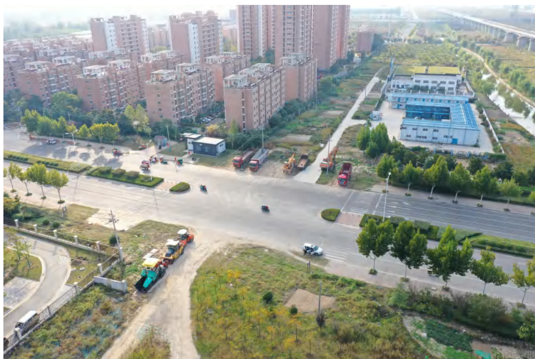
二期管道作业区
