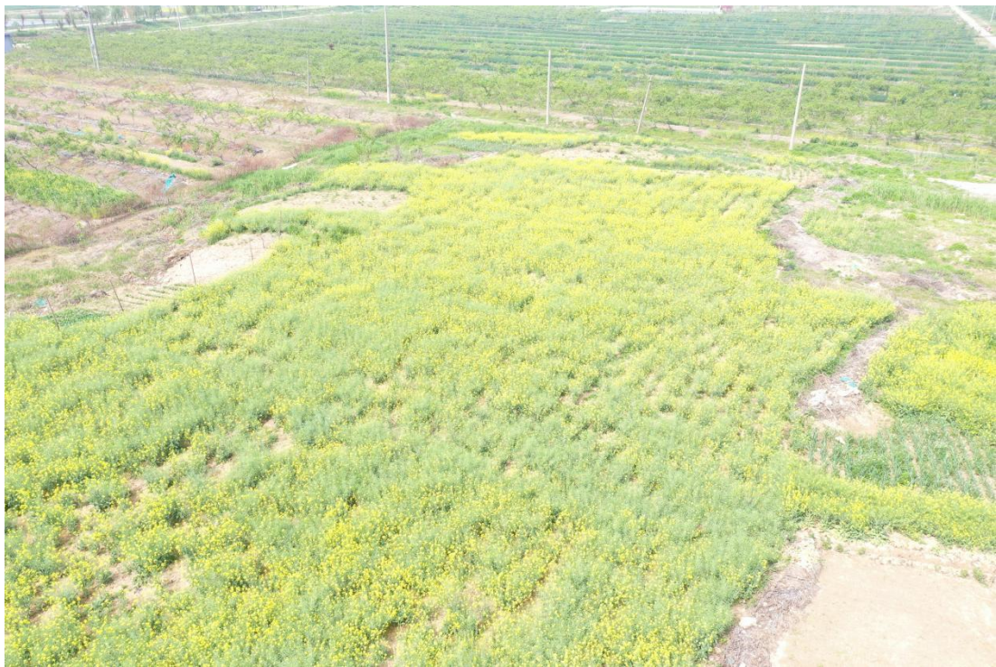
二期穿越作业区 撒播草籽 (2023.03)
