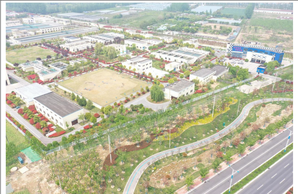
一期穿越作业区 撒播草籽 (2023.03)
