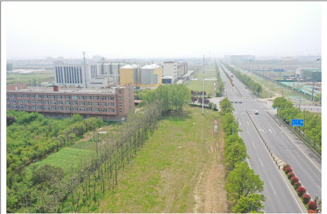
一期管道作业区 撒播草籽 (2023.03)
