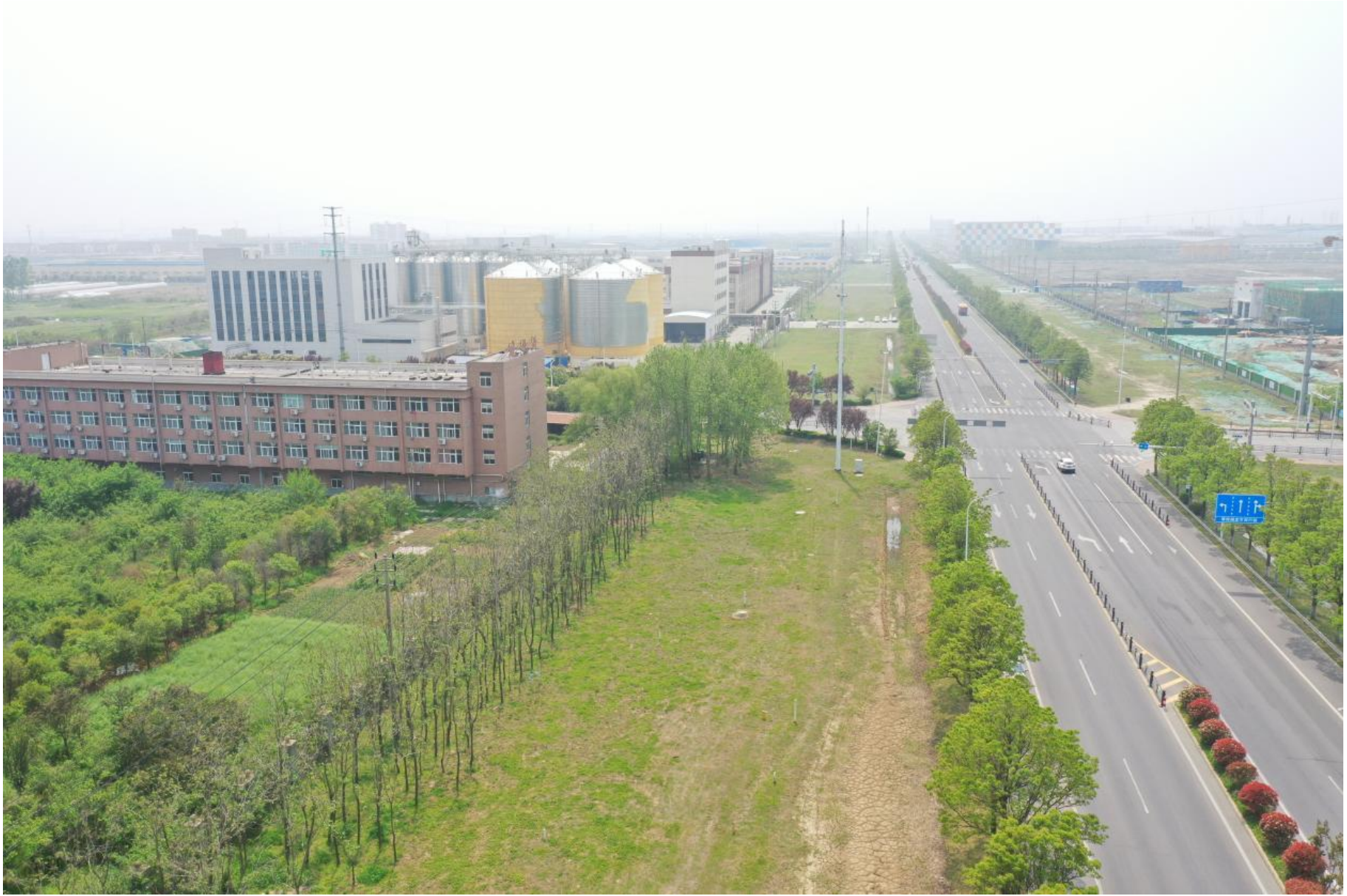
一期管道作业区 2023年3月
