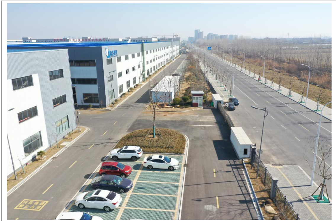
道路及配套设施区 透水铺装 (2023.01)
